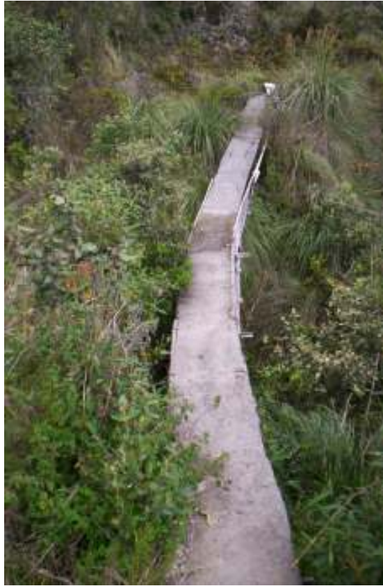
Fotografía No. 2.- Tubería expuesta cubierta por hormigón.
