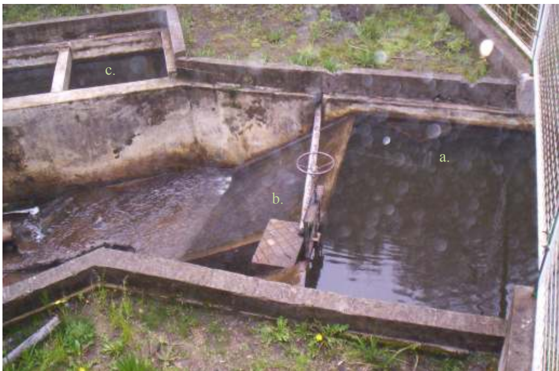
Fotografía No. 1.- Captación con detalles. a. Rejilla de fondo; b. Azud; c. Desarenador
