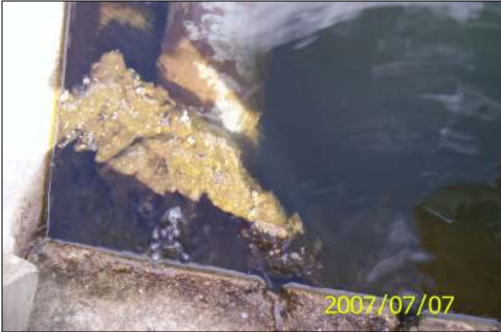
Fotografía No. 15.- Algas presentes en el tanque de filtración.
