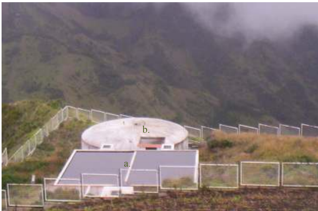
Fotografía No. 4.- a. Tanques de Filtración; b. Tanque de Reserva.
